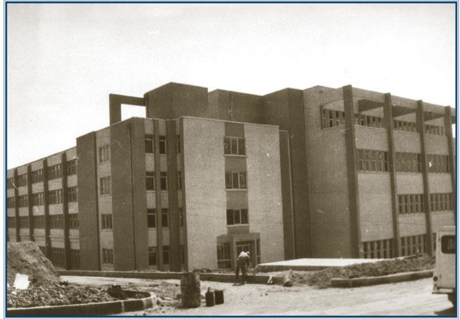
İTÜ Ayazağa yerleşkesindeki Elektrik-Elektronik Fakültesi Binasının inşaatı (1980, İTÜ Arşivi)
